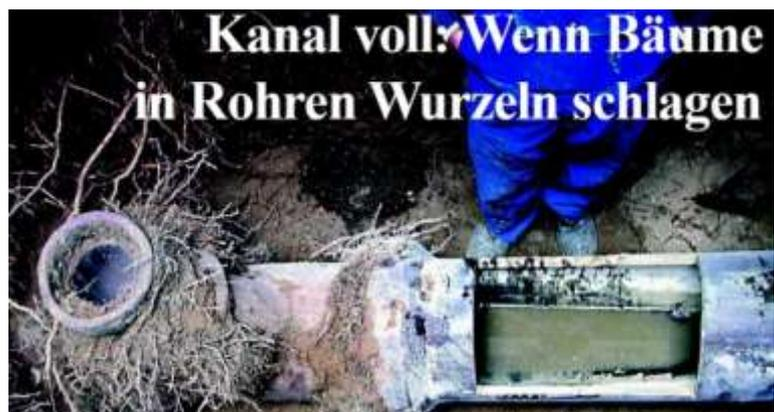
Auch eine Optimierung des Bettungsmaterials der Rohre durch den Einsatz flüssiger oder fester porenarmer Verfüllmaterialien mit dem Ziel der Minimierung bzw. Vermeidung der Durchwurzelbarkeit ist erforderlich. Die Trennung von Leitungsgraben (Künette) und Leitungstrasse kann dazu beitragen, das Risiko von Wurzelverletzungen bzw. Wurzelverlusten bei nachträglichen Aufgrabungen zu verringern.
